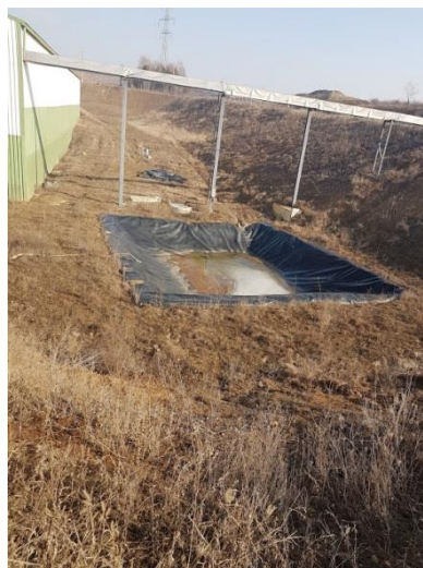
A Szuhakálló felől hiányos kerítés, eliszapolódott áteresztés .
