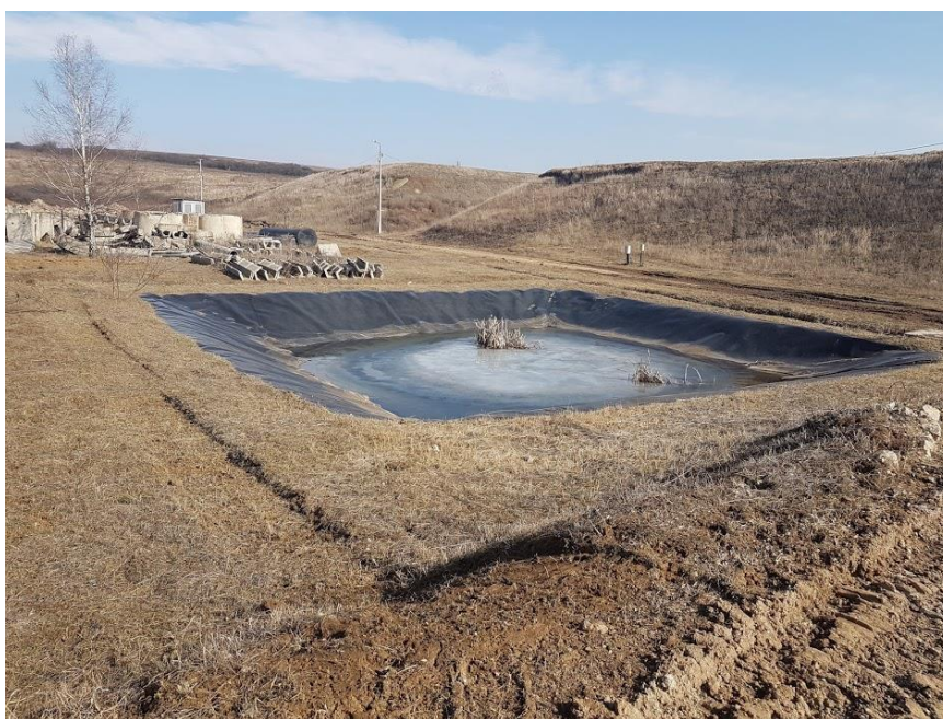
A csapadékvíz tározó medencék döntő többsége eliszapolódott
